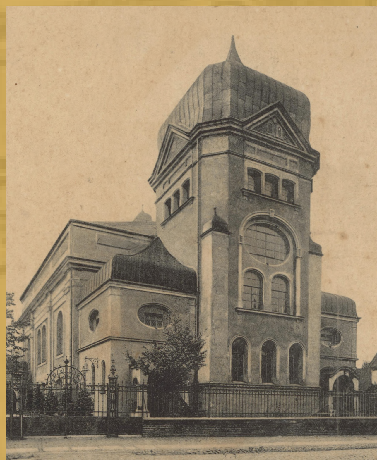
W 1905 roku Samuel Baeck poświęcił przebudowaną według projektu wrocławskich architektów – Richarda i Paula Ehrlichów leszczyńską synagogę; stan przed 1919; Muzeum Okręgowe w Lesznie, nr inw. MLH 4257
